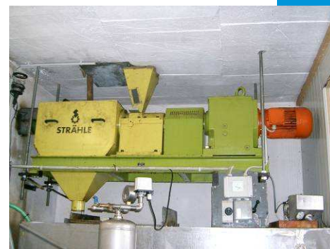
Presse de marque STRÄHLE au dessus du réservoir tampon
