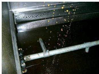
Réservoir tampon dans lequel tombe par gravité l'huile à la sortie de la presse
